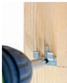
fissare il clip iniziale nella posizione segnata
