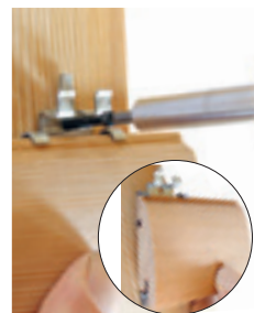
fissare il clip sulla sottostuttura
