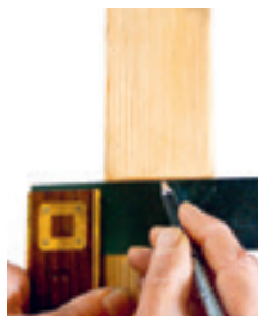
segnare la posizione orizzontale per il clip iniziale
